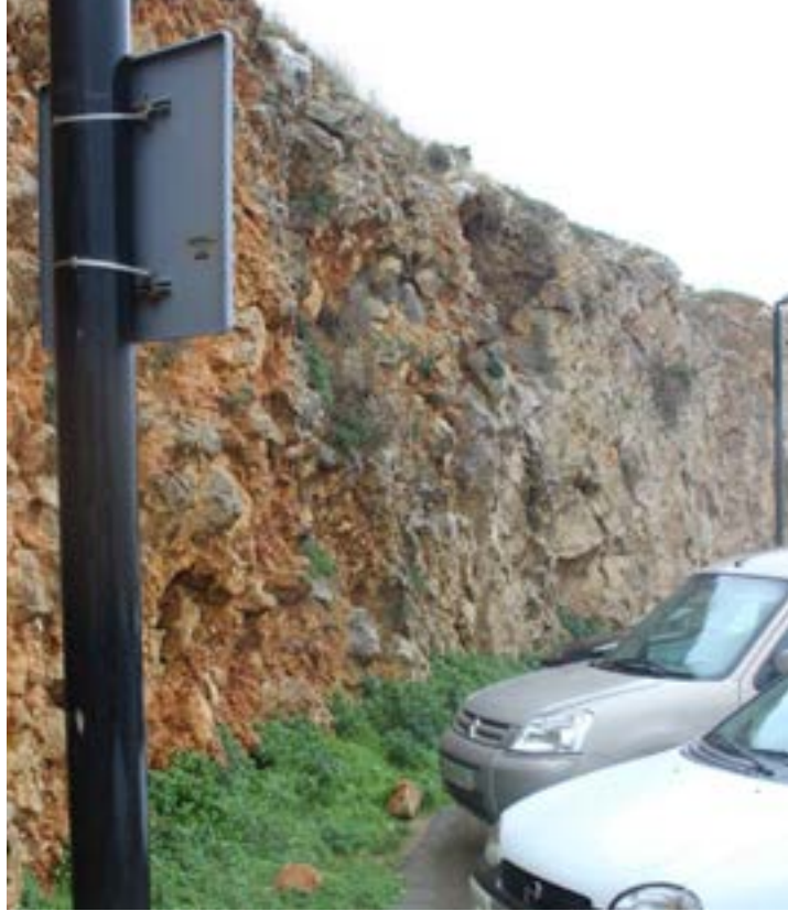
Fotografia 15. Detall del talús de l'aparcament del Pedró de la Creu on s'hi identifiquen dos blocs decimètrics caiguts al peu del talús, segurament desplaçats de la seva situació original per no interferir a l'aparcament.
